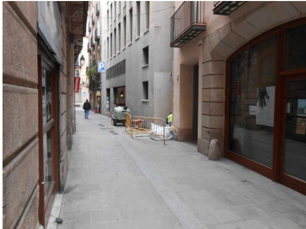
FOTO 9. Inici de les tasques d'excavació al carrer de Ripoll
