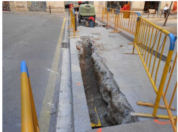
FOTO 6. Vista general de la rasa a l'alçada de la plaça d'Isidre Nonell
