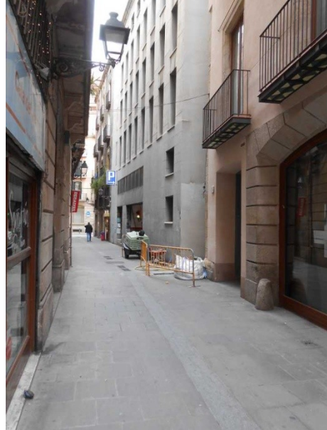
FOTO 2. Estat inicial de la intervenció al carrer de Ripoll
