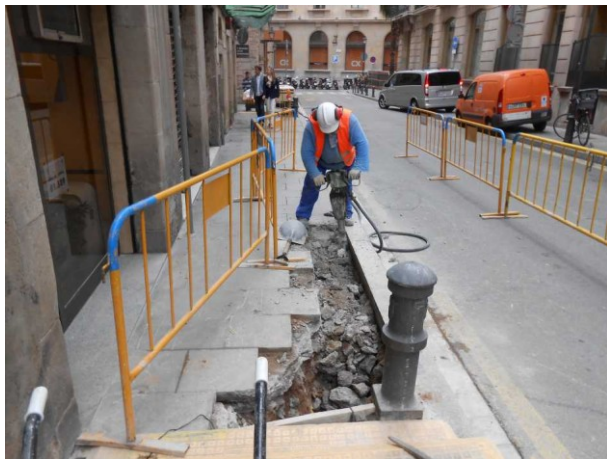
FOTO 7. Tasques d'excavació a l'alçada del número 5 del carrer de Capellans
