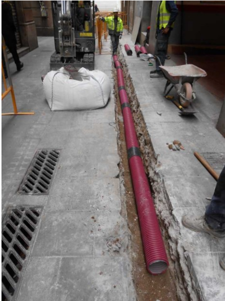
FOTO 13. Estat final. Col·locació del tub de servei
