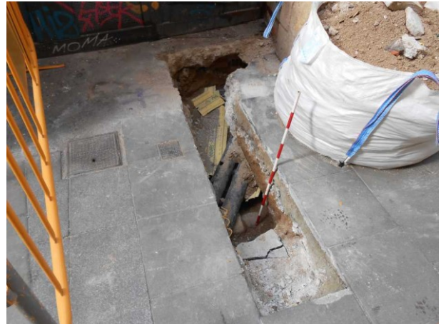
FOTO 10. Vista de detall de l'inici de la rasa al carrer de Ripoll
