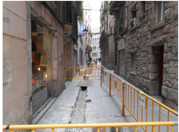
FOTO 12. Vista general de la rasa al carrer de Ripoll
